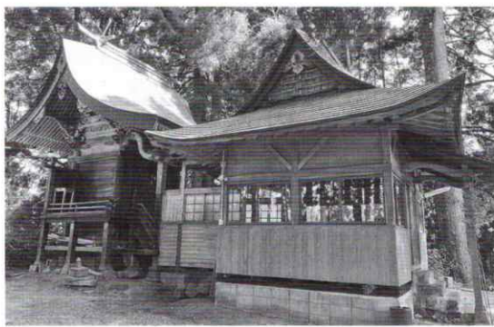
藤木村の菅原神社の神殿は安政2年(1855)に造営された。鞍岡祇園社と似た流造切妻平入の庇(ひさし)が伸びた美しい造りで要所には彫刻が施されている。後年造営された拜殿の色落ちした天井絵の花鳥図の修復に彩色した顔料が鮮やかで美しい。
